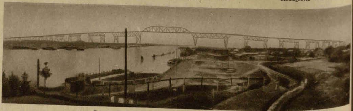
Ein Riesenwerk deutscher Technik Die große Eisenbahnhochbrücke bei Burg i. D. ist jetzt vollendet worden. Ihre Länge beträgt 2218 Meter, die Höhe vom Wasserpegel aus 42 Meter. Sie wurde in den Jahren 1914—1919 erbaut
