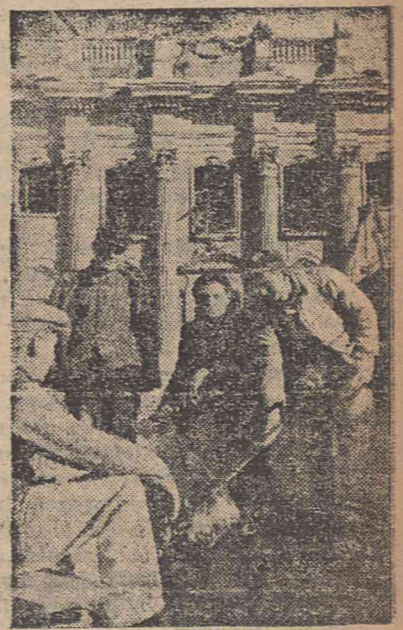
Odbudowa pałacu Pod Blachą. Robotnicy przed pałacem grzeją się w czasie przerwy obiadowej.
