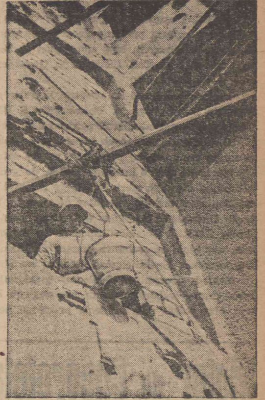
Siostry Urszulanki remontują swój dom w Warszawie, przy ul. Ks. Stemca 2. Na zdjęciu siostra Marcelina odbiera kubek z zaprawą murarską.
