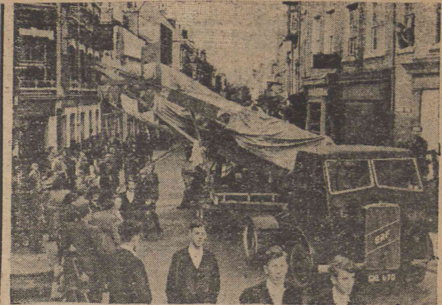
Pierwsze brytyjskie latające skrzydło o napędzie rakietowym, AW 52, przewożone z lotniska Baginton, Coventry, szosą do Boscombe Down, Hampstead na próbę lotu. Latarnie uliczne musiały być usunięte, drzewa poćcinane i sbudowany specjalny most dla tego dziwnego prze- wozu samolotu brytyjskiego. Foto Keystone przez SAP.
