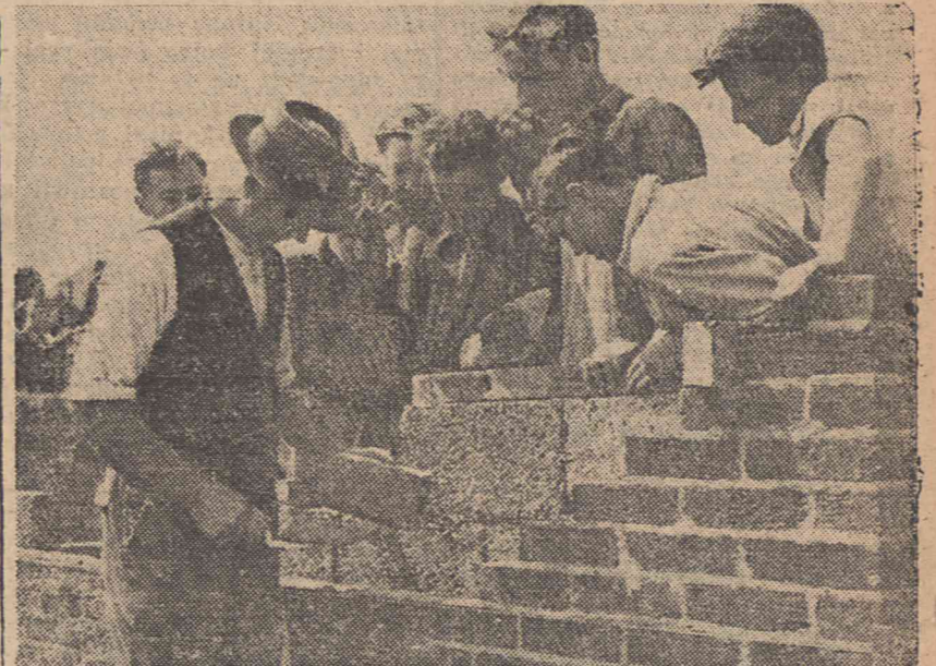
Młodzież angielska uczęszcza przede wszystkim do szkół zawodowych. Na zdjęciu grupa młodzieży uczącej się rzemiosła murarskiego. I nasza młodzież będzie się uczyć w tym roku murarstwa, aby odbudować zniszczone wsie i miasta, aby odbudować stolicę.
