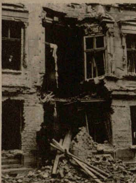
Durch Mine verwüstetes Haus in der Alten Schützenstraße
