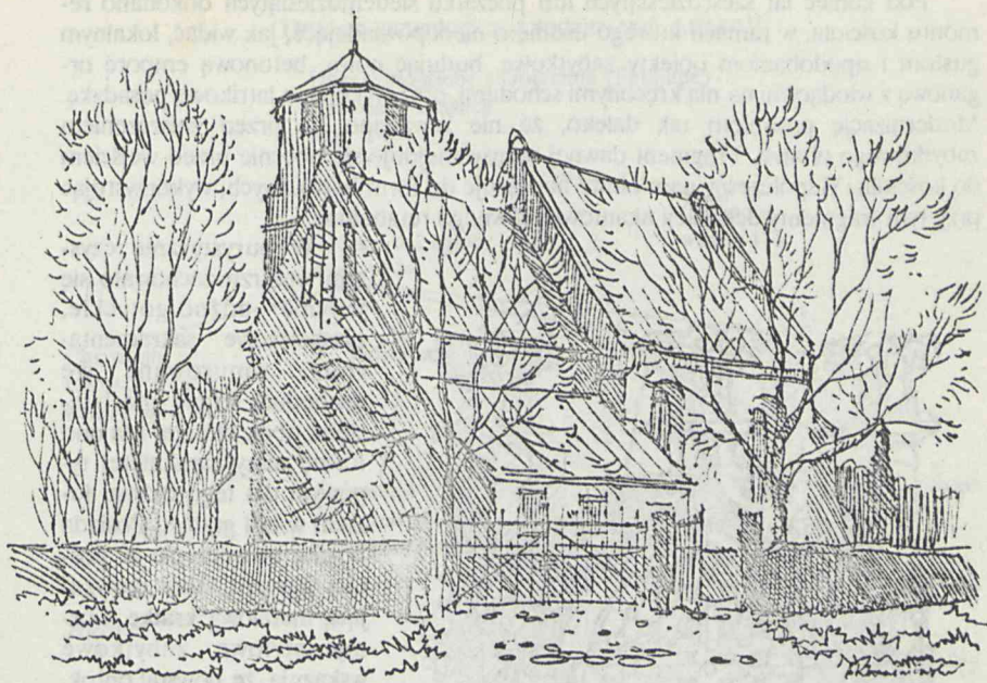
Rys. 1. Kościół św. Antoniego w Niemstowie, widok od północnego-wschodu.
