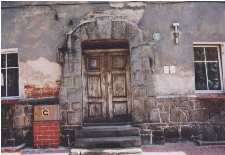
Fot. 138. ul. Wolności 37 — budynek mieszkalny, portal. Nr neg. 5810.
