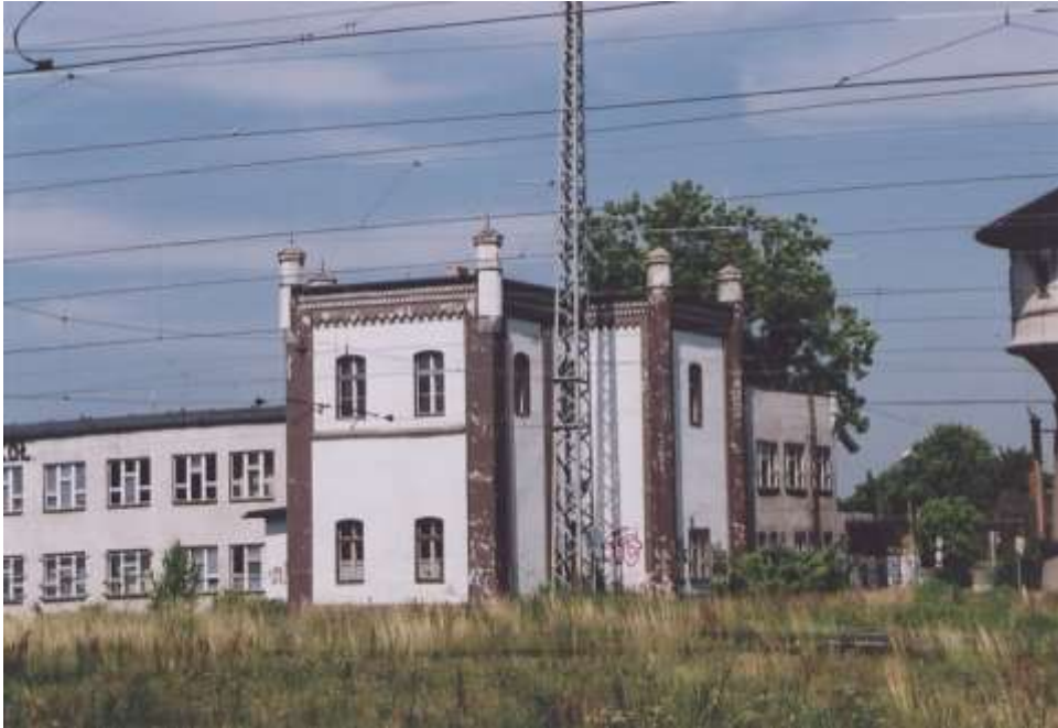
Fot. 153. Biura dawnej wagonowni, obecnie część budynku szkolnego. Nr neg. 5977.
