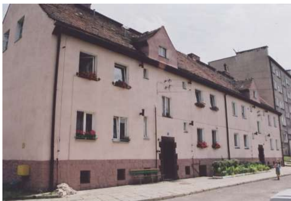
Fot. 12. ul. L. Ekerta 3-3a — budynek mieszkalny. Nr neg. 5846.
