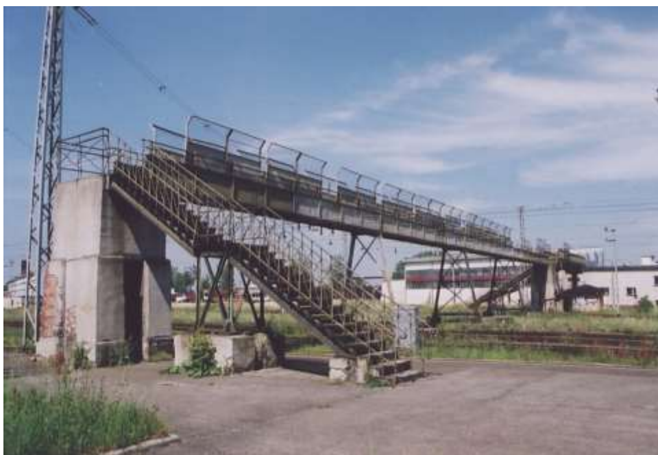
Fot. 155. Kładka dla pieszych. Nr neg. 5985.
