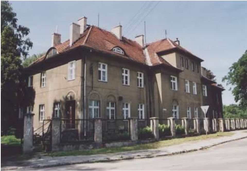
Fot. 27. ul. Kasztanowa 1-3-5 — budynek mieszkalny. Nr neg. 5794.
