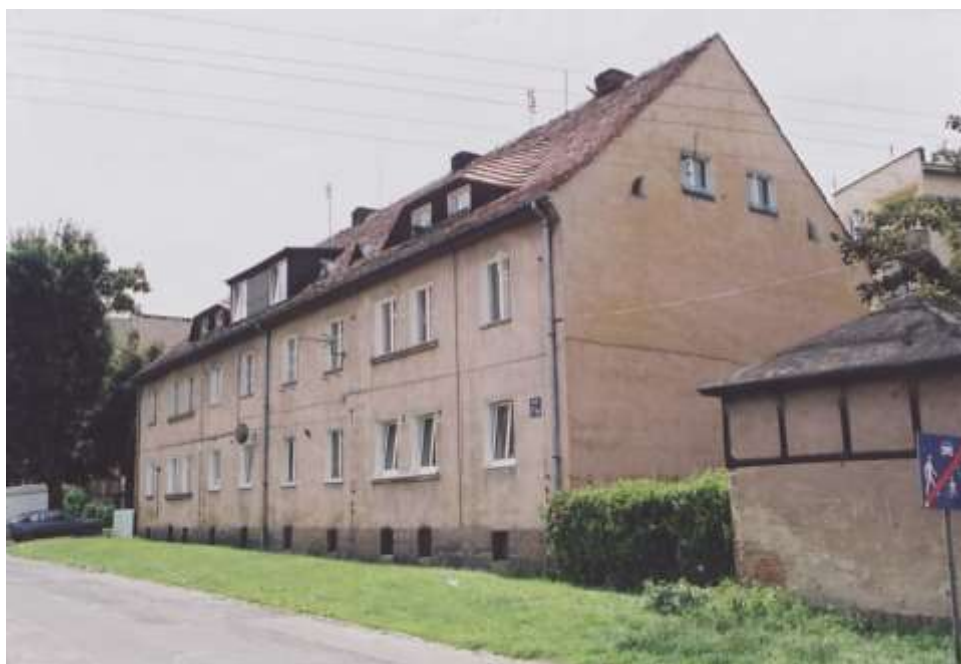
Fot. 11. ul. L. Ekerta 1 -1 a — budynek mieszkalny. Nr neg. 5844.
