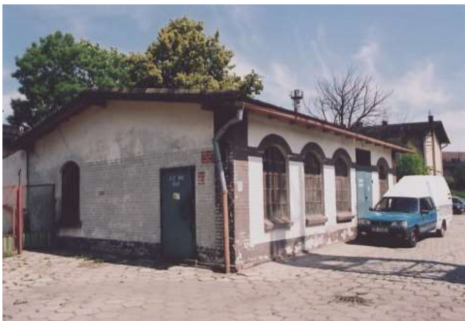
Fot. 158. Warsztaty kolejowe. Nr neg. 5994.
