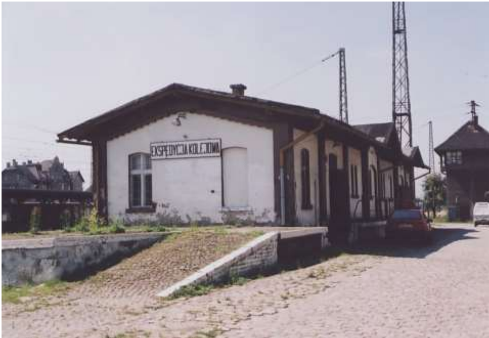
Fot. 151. Budynek ekspedycji kolejowej. Nr neg. 5992.
