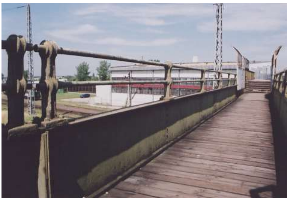
Fot. 157. Kładka dla pieszych. Nr neg. 5983.
