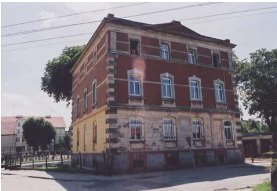
Fot. 94. ul. J. Słowackiego 9 — gospoda, obecnie w wydzielonej części budynku Niepubliczny ZOZ „Sanus”. Nr neg. 5815.
