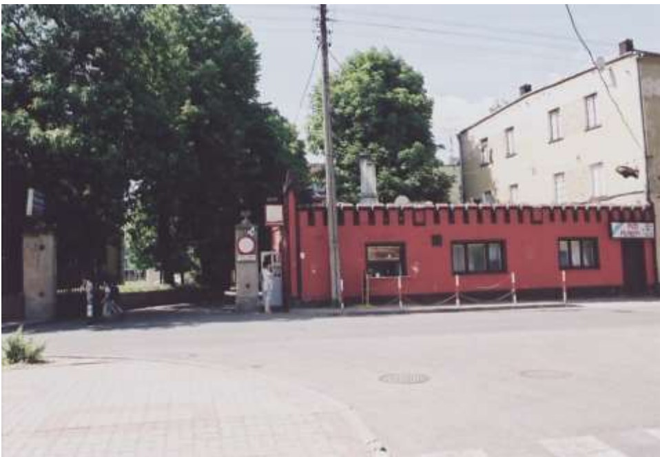
Fot. 168. Pierwotny wjazd na teren fabryki; ciąg budynków ZPS „Karolina” S.A. wzdłuż ul. Wolności 2/4. Nr neg. 5801.
