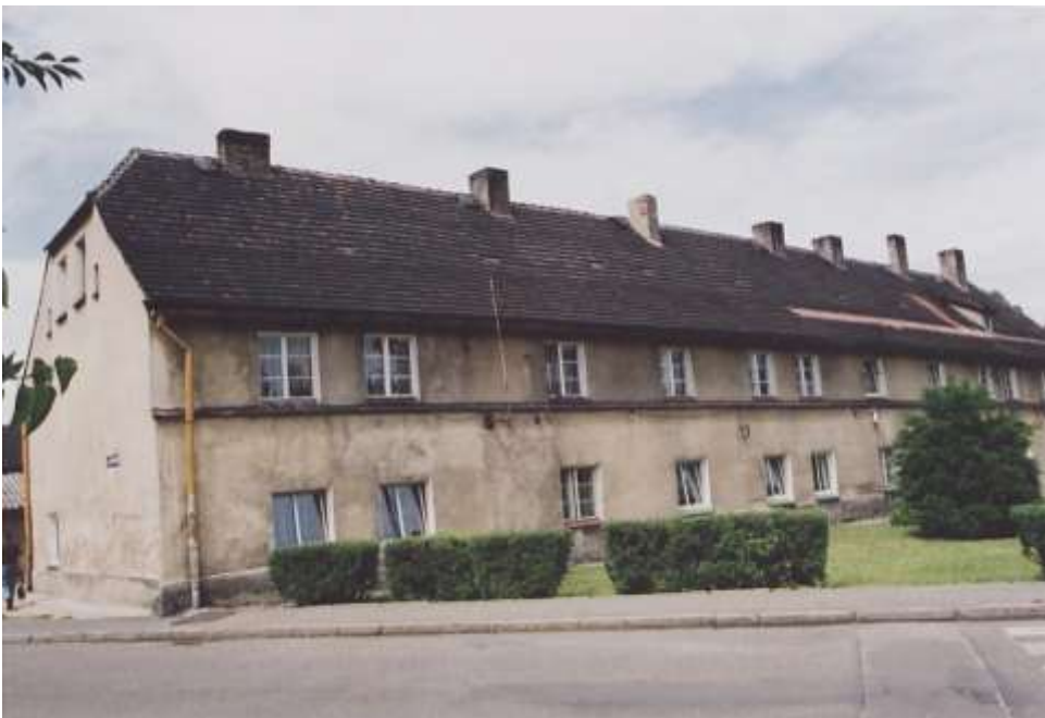
Fot. 16. ul. Jana Pawła II 6-6a-6b-6c — budynek mieszkalny. Nr neg. 5853.
