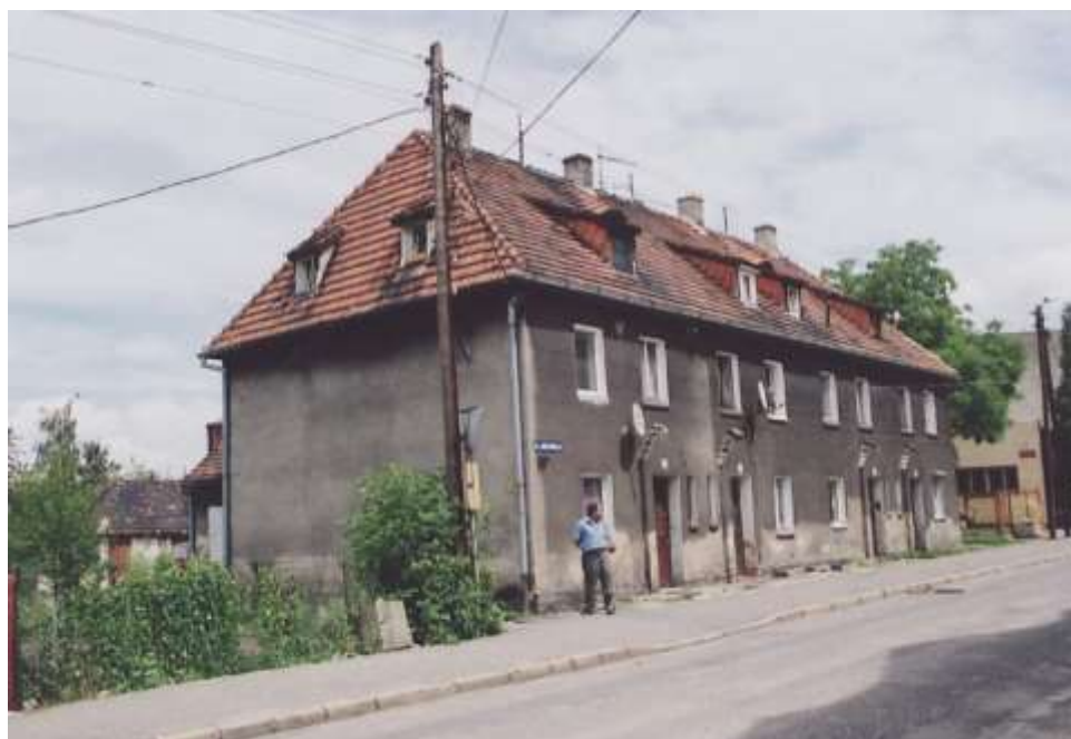
Fot. 24. ul. Jana Pawła II 14-14a-14b-14c — budynek mieszkalny. Nr neg. 5840.
