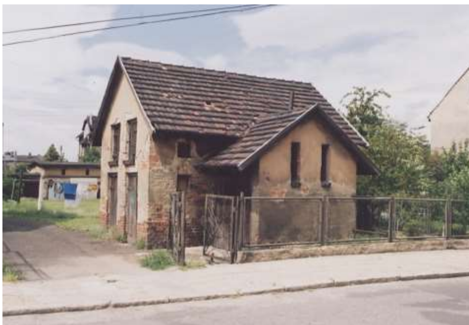
Fot. 52. ul. T. Kościuszki 19 — budynek gospodarczy. Nr neg. 5862.
