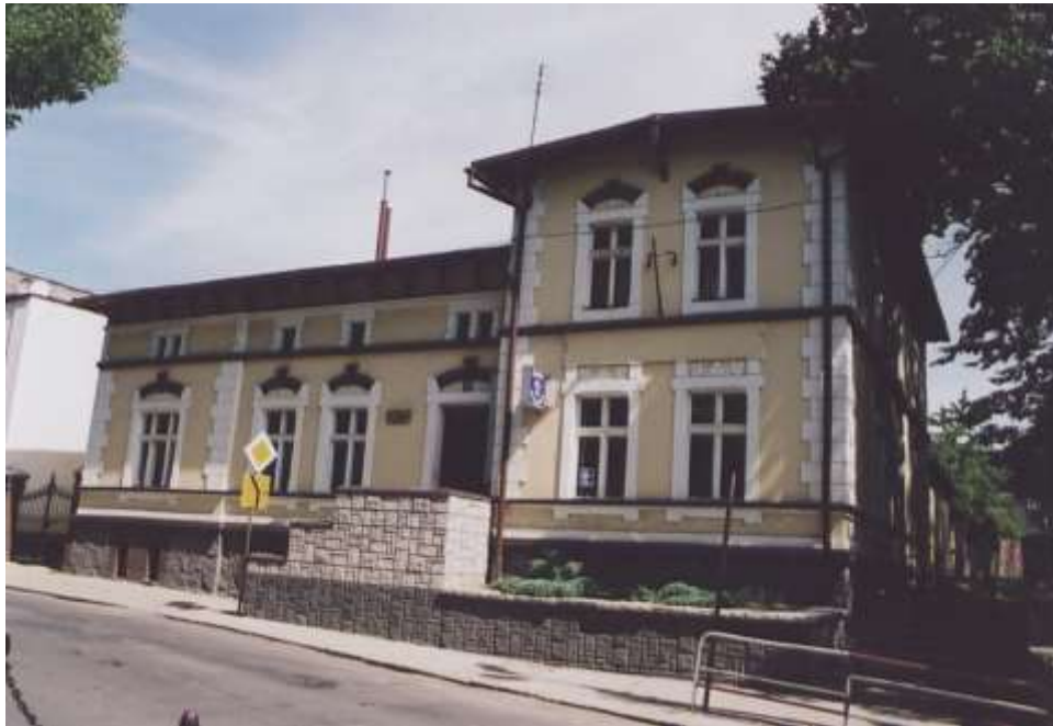
Fot. 123. ul. Wolności 5 — budynek mieszkalny, apteka. Nr neg. 5797.
