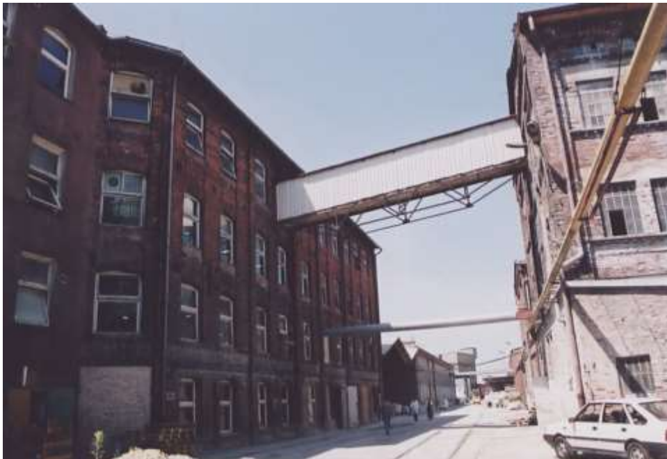
Fot. 164. ZPS „Karolina” S.A. — budynek produkcyjny (dawna piecownia, obecnie modelarnia i odlewnia form gipsowych oraz biura). Nr neg. 6001.
