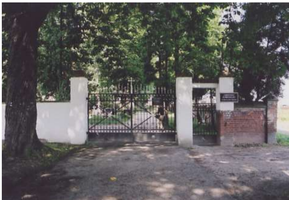
Fot. 9. Cmentarz parafialny, mur cmentarny z bramą. Nr neg. 5790.
