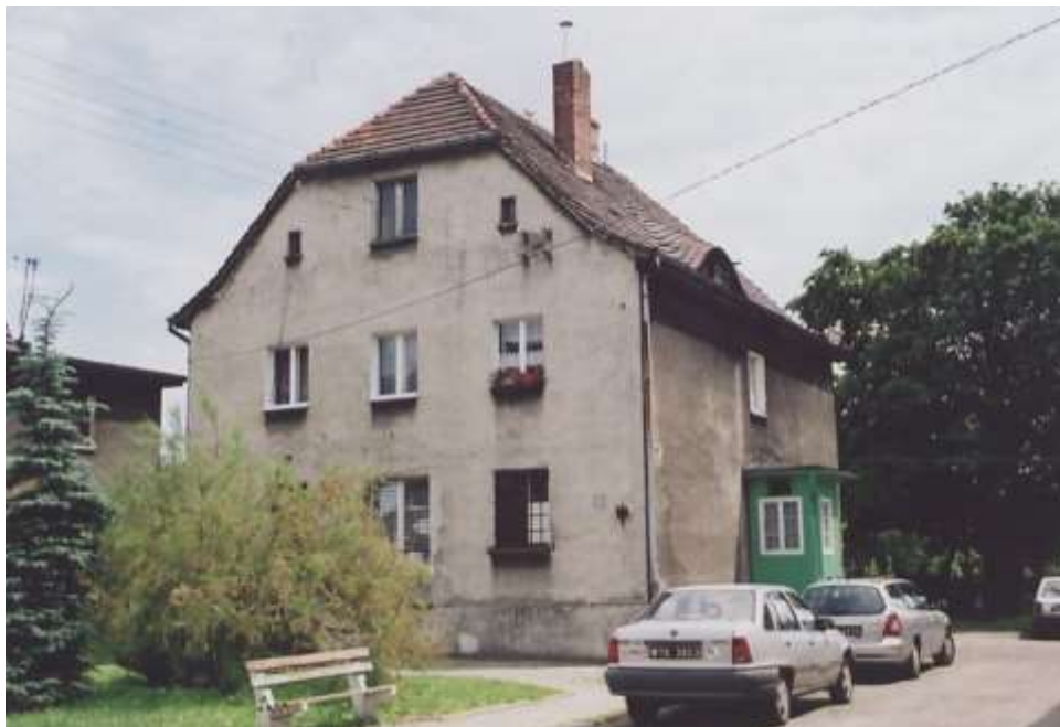
Fot. 38. ul. T. Kościuszki 8 — budynek mieszkalny, obecnie punkt przyjęć bezrobotnych. Nr neg. 5828.
