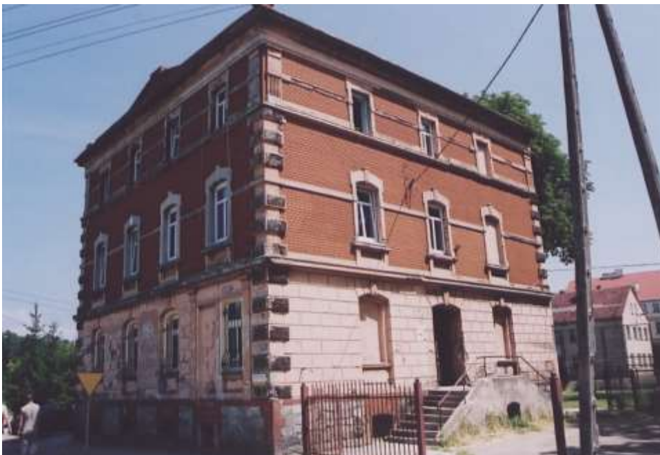
Fot. 96. ul. J. Słowackiego 9 — gospoda, obecnie w wydzielonej części budynku Niepubliczny ZOZ „Sanus”. Nr neg. 6005.
