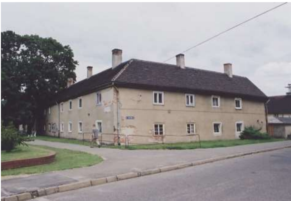
Fot. 14. ul. Jana Pawła II 4, 4a, 4b, 4c, 4d — budynek mieszkalny. Nr neg. 5856.
