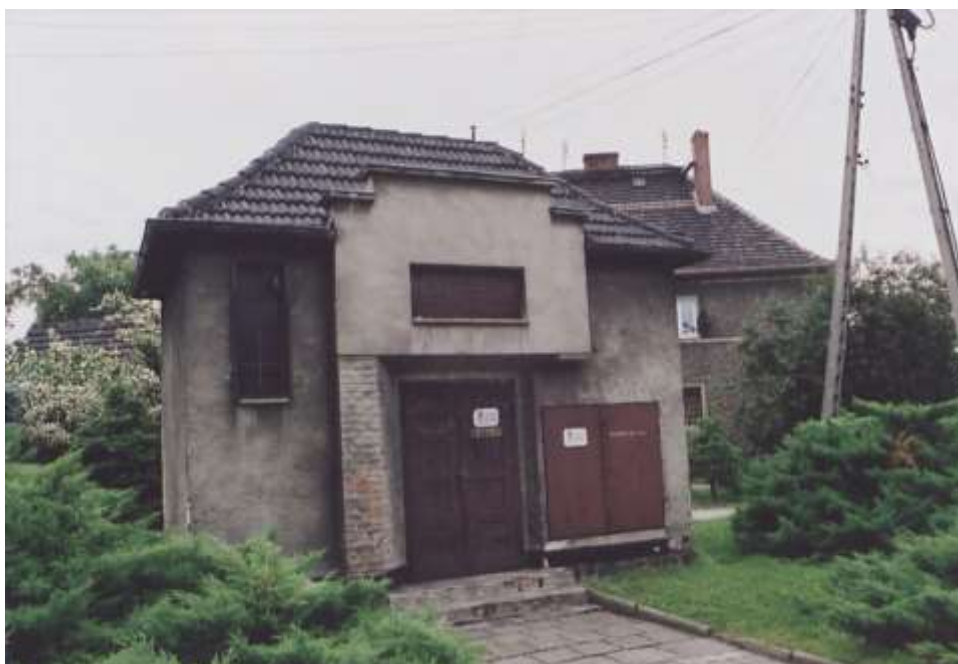
Fot. 25. ul. Jana Pawła II — trafostacja. Nr neg. 5858.
