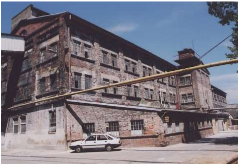
Fot. 162. ZPS „Karolina” S.A. — hale produkcyjne (odlewnia, formownia, palarnia, magazyn wyrobów gotowych). Nr neg. 6000.
