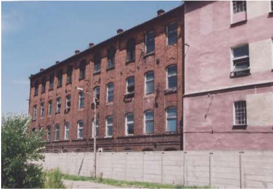
Fot. 165. ZPS „Karolina” S.A. — budynek produkcyjny (dawna piecownia, obecnie modelarnia i odlewnia form gipsowych oraz biura). Nr neg. 5996.
