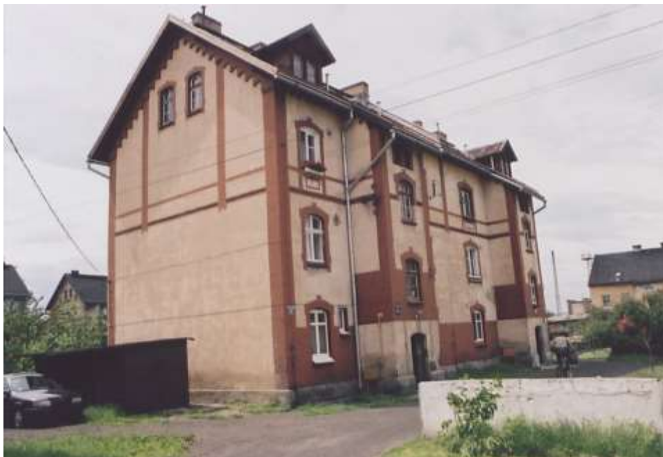
Fot. 53. ul. T. Kościuszki 19 a-b — budynek mieszkalny. Nr neg. 5863.
