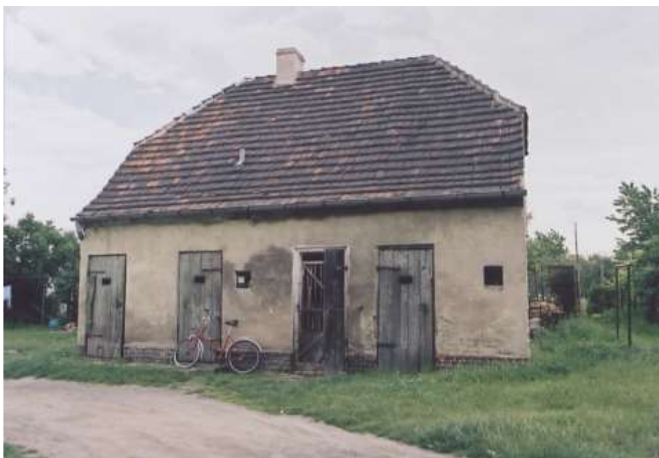
Fot. 71. ul. 1 Maja 52-54 — budynek gospodarczy. Nr neg. 5887.
