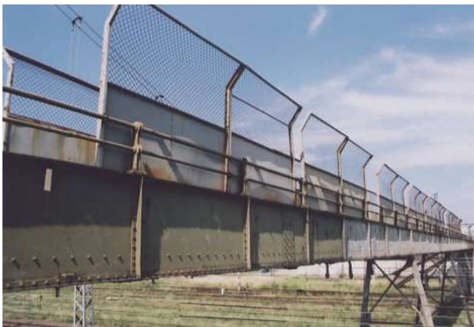
Fot. 156. Kładka dla pieszych. Nr neg. 5984.
