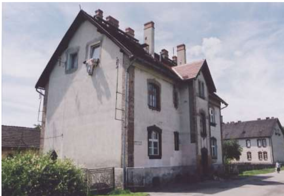
Fot. 79. ul. Ogrodowa 2 — budynek mieszkalny. Nr neg. 5770.
