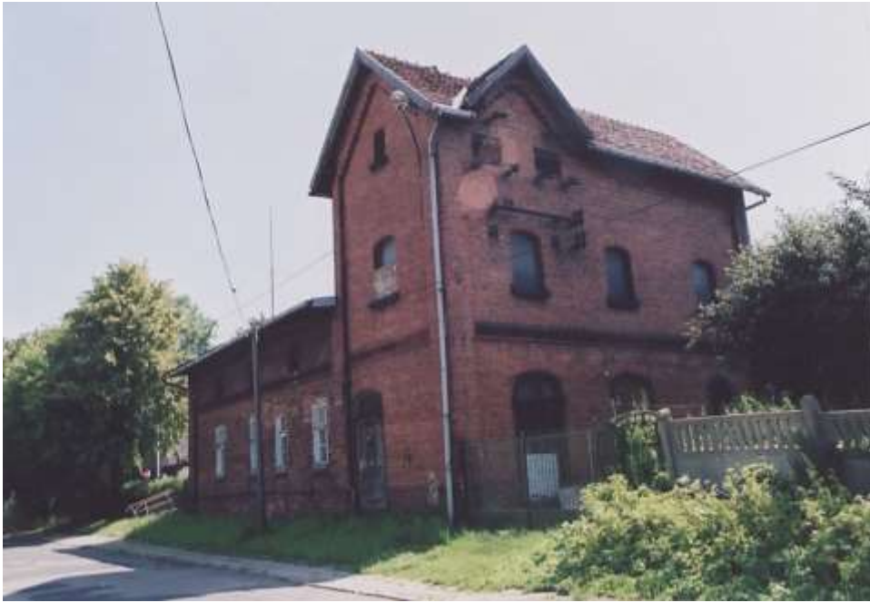
Fot. 89. ul. Powstańców Śl. 8 — budynek mieszkalny i tranfostacja. Nr neg. 5995.
