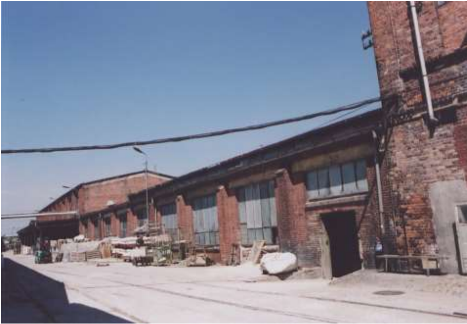
Fot. 163. ZPS „Karolina” S.A. — hale przemysłowe (kompletownia). Nr neg. 6002.
