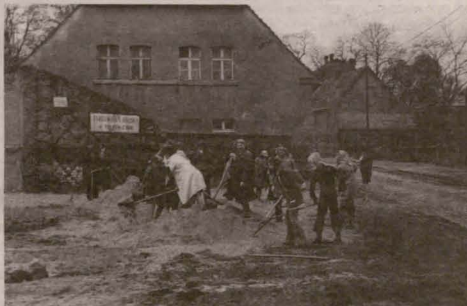
Czyn społeczny pracowników GS przy budowie targowiska miejskiego Jedno ze zdjęć udostępnionych przez Pana Ryszarda Figasa
