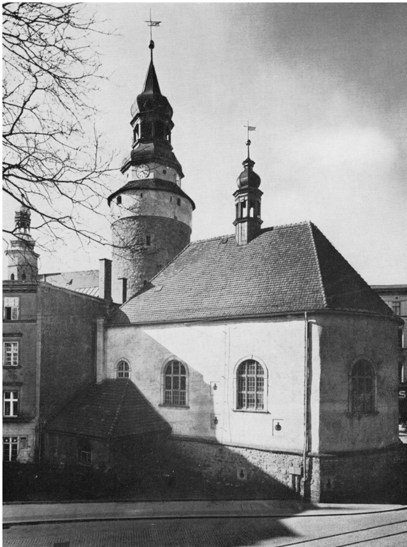
Kaplica św. Anny po lewej stara wieża bramna, po prawej przy oknie 4 otwory strzelnicze.
