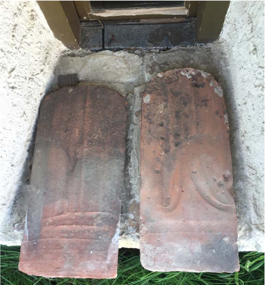
Alte handgestrichene Biberschwanz–Dachziegel, vermutlich von der ersten Dachdeckung.
