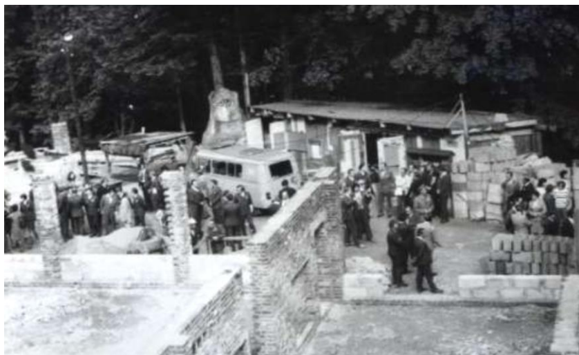
Teren budowy, stan wykonanych prac
