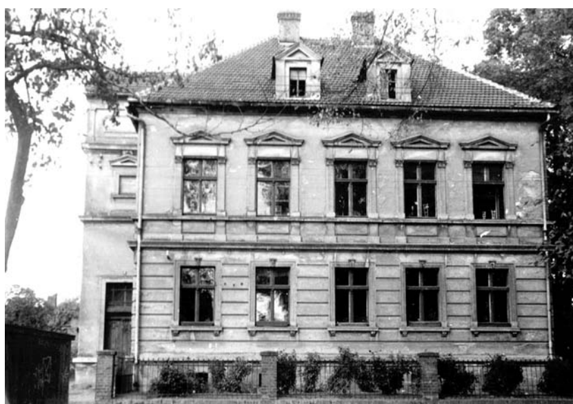
(058) Budynek nr 2 szkoły w roku 1957-58
