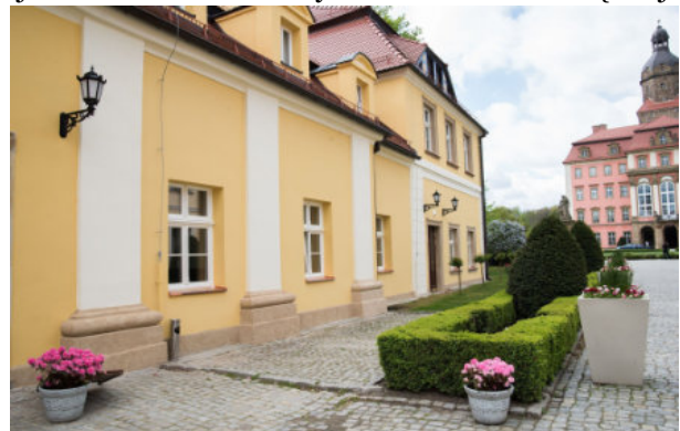
Dom Kawalerów po remoncie
