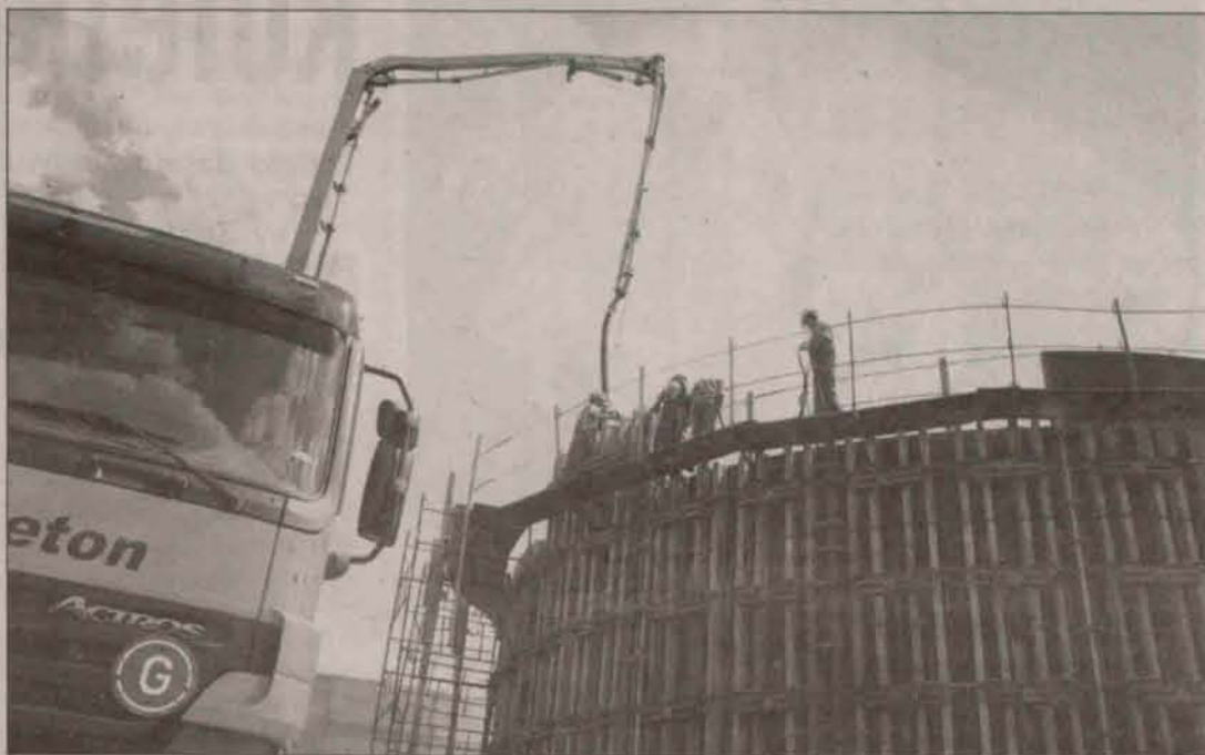
Miejska oczyszczalnia ścieków
