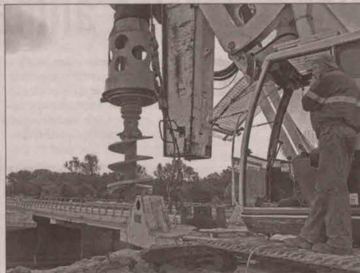
Na plac budowy wjechał ciężki sprzęt
