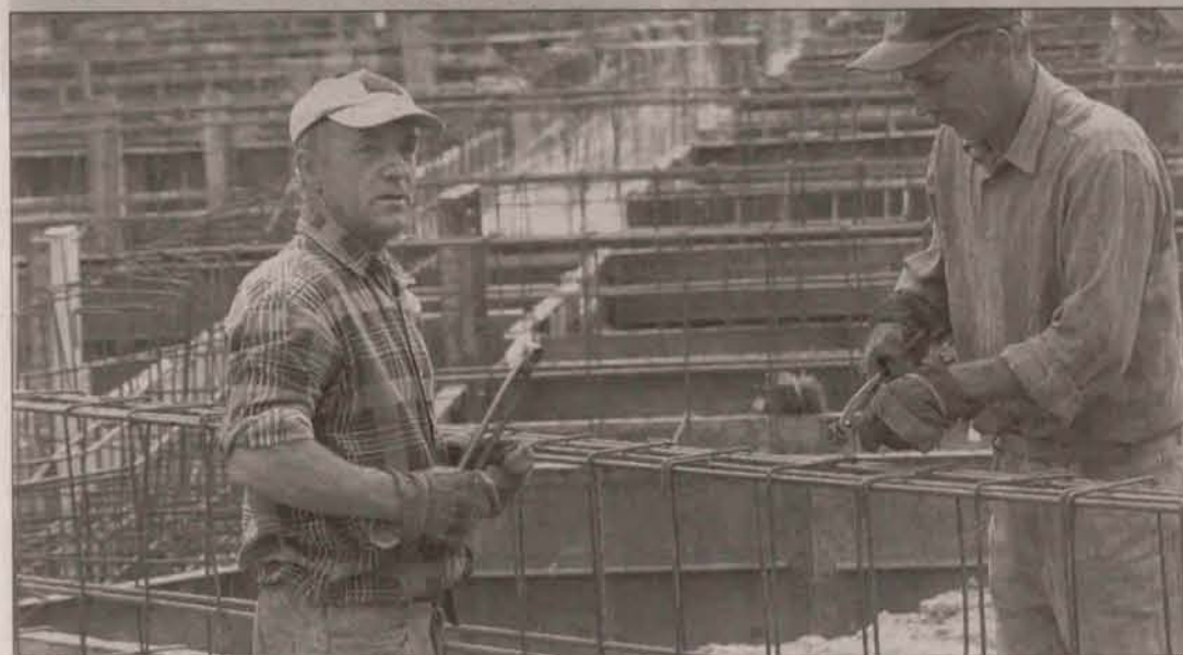
Rok temu na placu budowy pracowali zbrojarze
