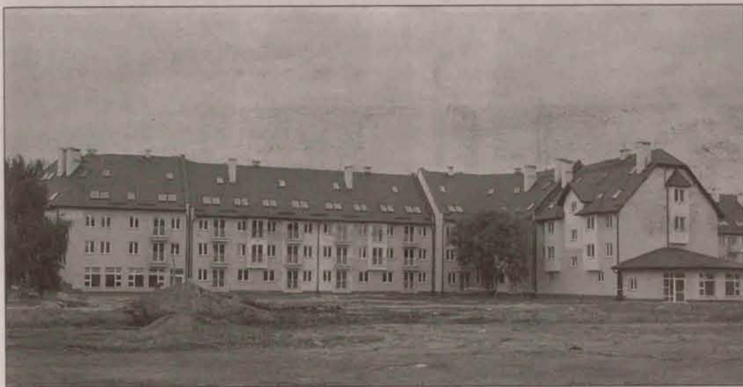
Tak wyglądał nowy budynek dwa dni przed oficjalnym otwarciem.
