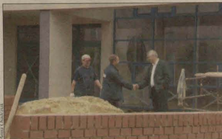
Wszystko przebiega zgodnie z planem i prace nad budową gimnazjum dobiegają końca
