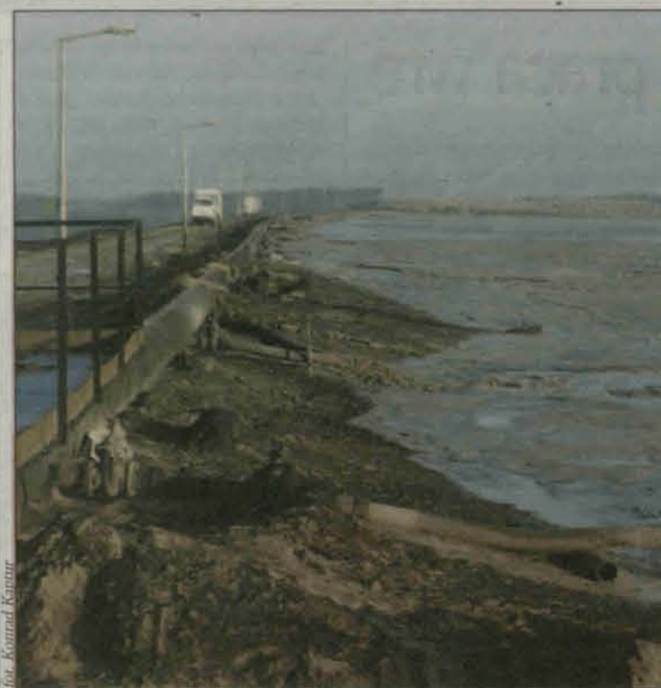
Zbiornik odpadów poślotacyjnych - Żelazny Most
