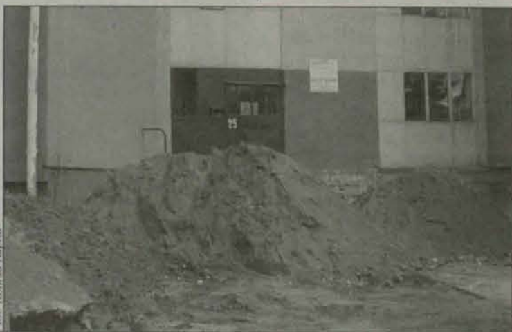
Przy ulicy Skalników rozpoczęto prace budowlane
