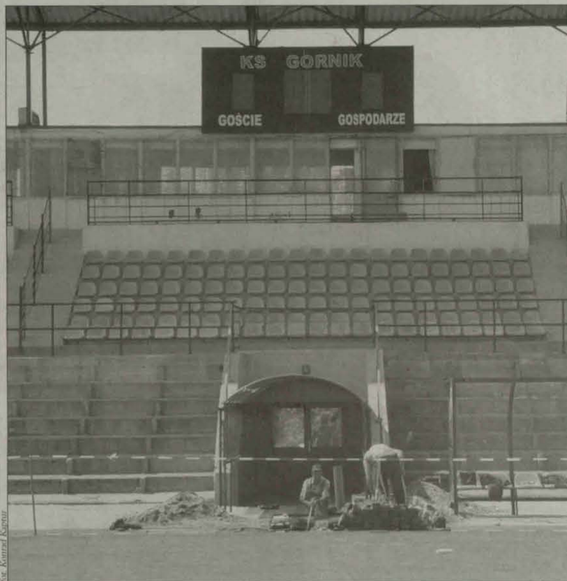
Tak wyglądał stadion Górnika Polkowice przed inauguracyjnym meczem z Wisłą Kraków. Już wkrótce będzie on powodem do dumy dla każdego kibica
