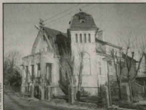
Palac przeznaczony do rozbiórki
