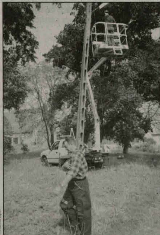
Naprawa uszkodzonej latarni
