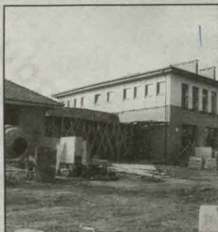
Budowa łącznika jeszcze trwa
