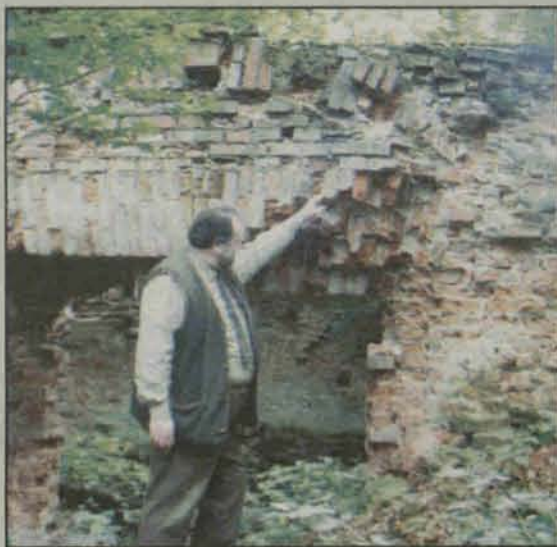
Widok budowli z zewnątrz
