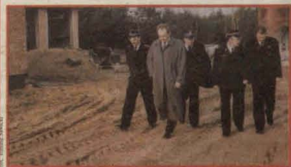
Wizyta Emiliana Stańczyszyna na budowie nowej strażnicy
