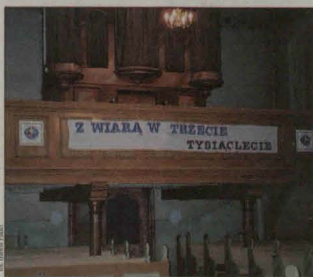
W trakcie prac malarskich w świątyni
