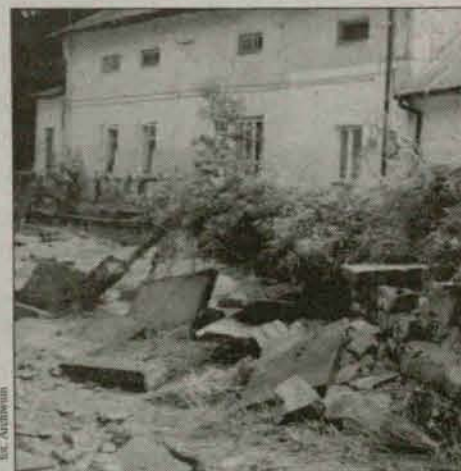
Skutki lipcowej powodzi odczuwane są do dziś
