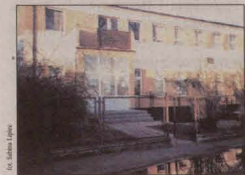
Ośrodek zdrowia po kapitalnym remoncie
