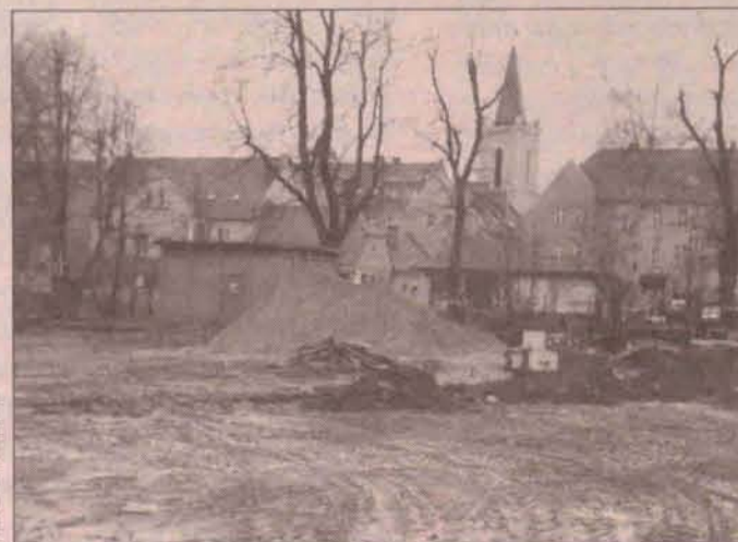
Prace budowlane już trwają
