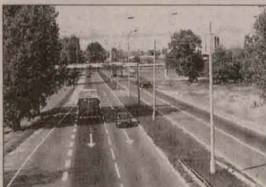
Niezbędna jest modernizacja drogi krajowej A3
