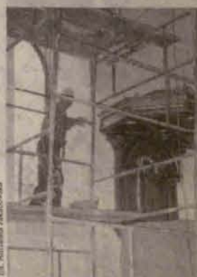
Zakończenie prac remontu kościoła
