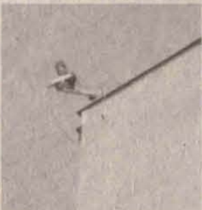
Kamera na dachu
