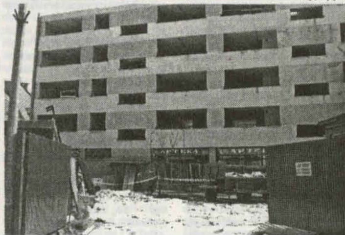
Zarząd Polkowic postanowił o wstrzymaniu prac rozbiórkowych pierzei północnej polkowickiego rynku.
