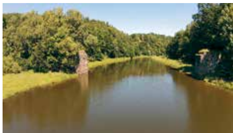
Gmina wspólnie z Gminą Leśna i Powiatem Lubańskim odbuduje kładkę łączącą Bożkowice ze Stankowicami, która docelowo ma połączyć ścieżką rowerową obie gminy oraz Zamek Rajsko z Zamkiem Czocho
