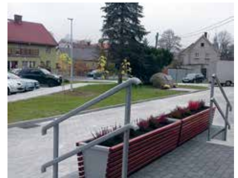
Zmodernizowany Plac Kardynała Wyszyńskiego
