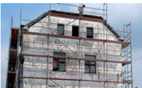
Budynek w trakcie prac modernizacyjnych
