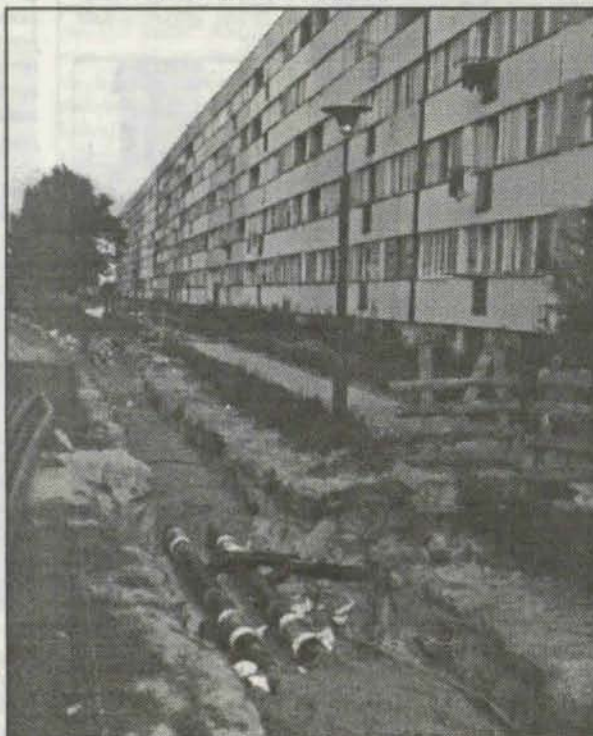
Wymiana kanalizacji na ul. Lipowej.
