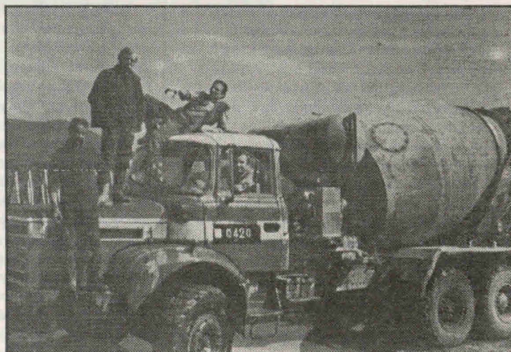
Pracownicy ZBK na budowie w Algierii
