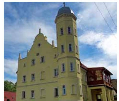
Wyremontowany pałac w Olszynie, w którym mieszczą się mieszkania komunalne.
