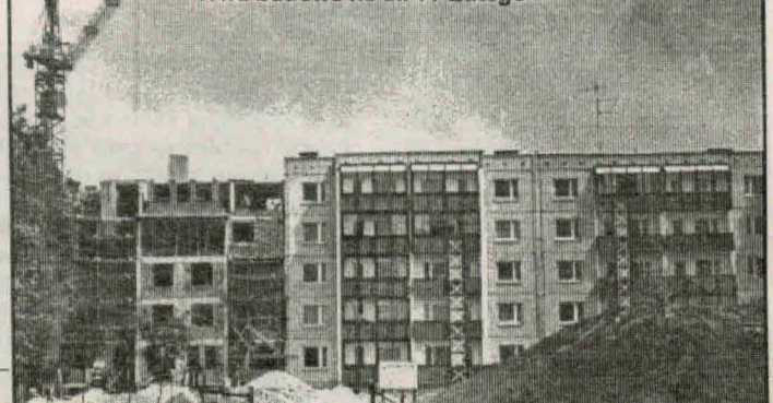
Trwa budowa na ul. 11-Lutego
