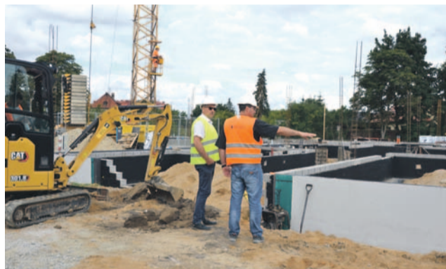
Wicestarosta Witold Niemirowski spotkał się na placu budowy z przedstawicielami firmy realizującej inwestycję
