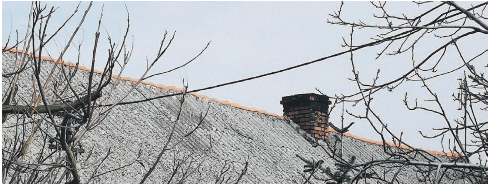
Dach kryty eternitem
