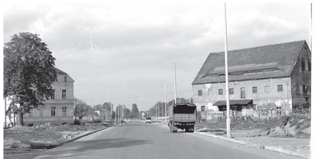
Rok 1971. Ulica 3 Maja w budowie. Jest już położona nawierzchnia asfaltowa, ale pobocza to krajobraz księżycowy. Po lewej stronie, w głębi, nieśmiało zaczął funkcjonować dziki handel, wtedy nie było budynku Starostwa. Po prawej przedwojenny budynek - potem wyburzony. W głębi na końcu charakterystyczny przedwojenny budynek przy ul. Żeromskiego 4
