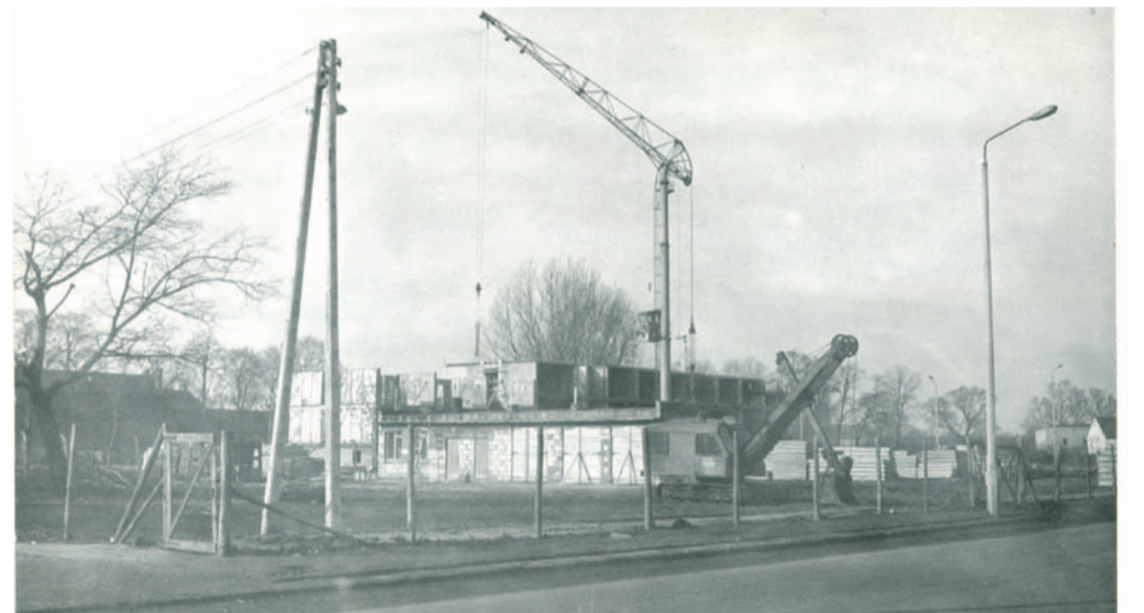
W miejscu, gdzie był Koński Targ, trwa budowa budynku, w którym przez lata był Hotel Robotniczy dla pracowników Wrocławskiego Przedsiębiorstwa Budowlanego „Północ” - firmy, która budowała Oławę, a dziś już nie istnieje. W 1997 zaczęło funkcjonować w tym budynku Starostwo Powiatowe
