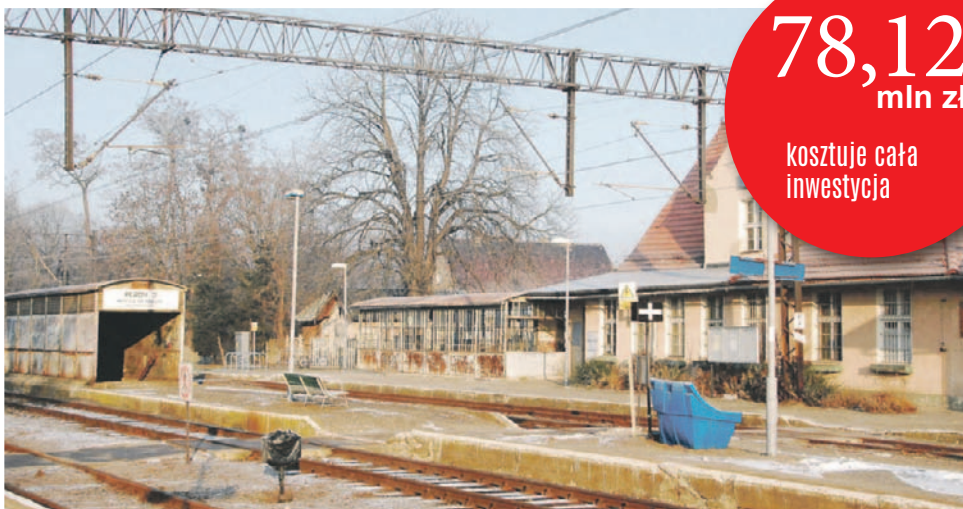
A stary dworzec w Jelczu-Laskowicach od lat czeka na remont
