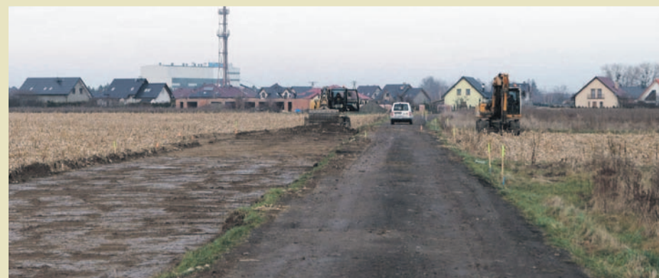
Na trwającą budowę ul. Gajowej otrzymaliśmy dofinansowanie z Funduszu Dróg Samorządowych w wysokości 1 022 221,20 zł
