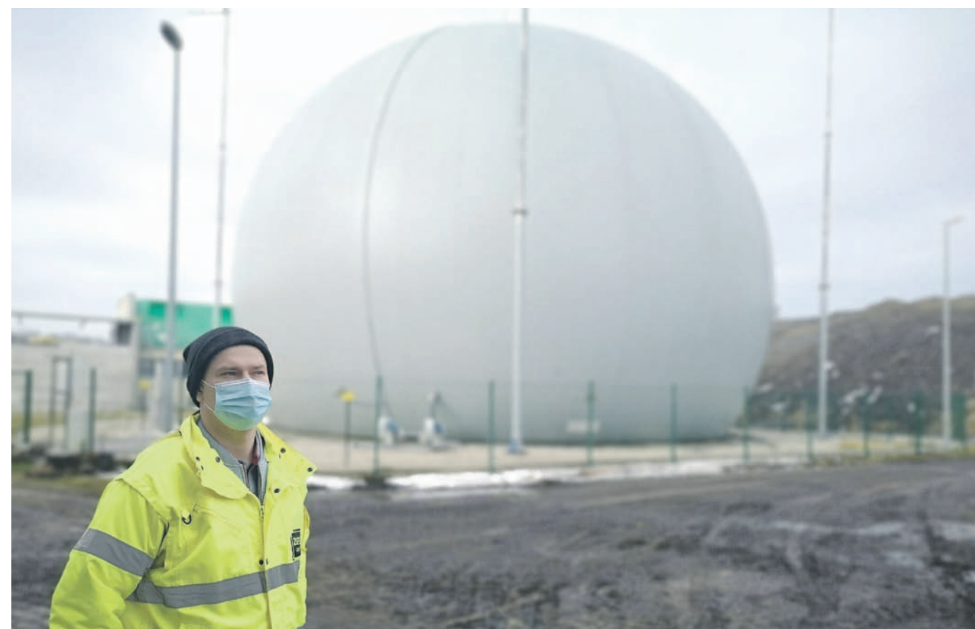
- Z każdej tony wsadu, którą wrzucimy do komory fermentacyjnej, uzyskujemy od 105 do 115 metrów sześciennych biogazu - mówi dyrektor Zakładu Gospodarowania Odpadami Gać Sp. z o.o. Przemysław Seruga. Gaz ten jest magazynowany w tej wielkiej kuli i pojemności 4 tys. metrów sześciennych
