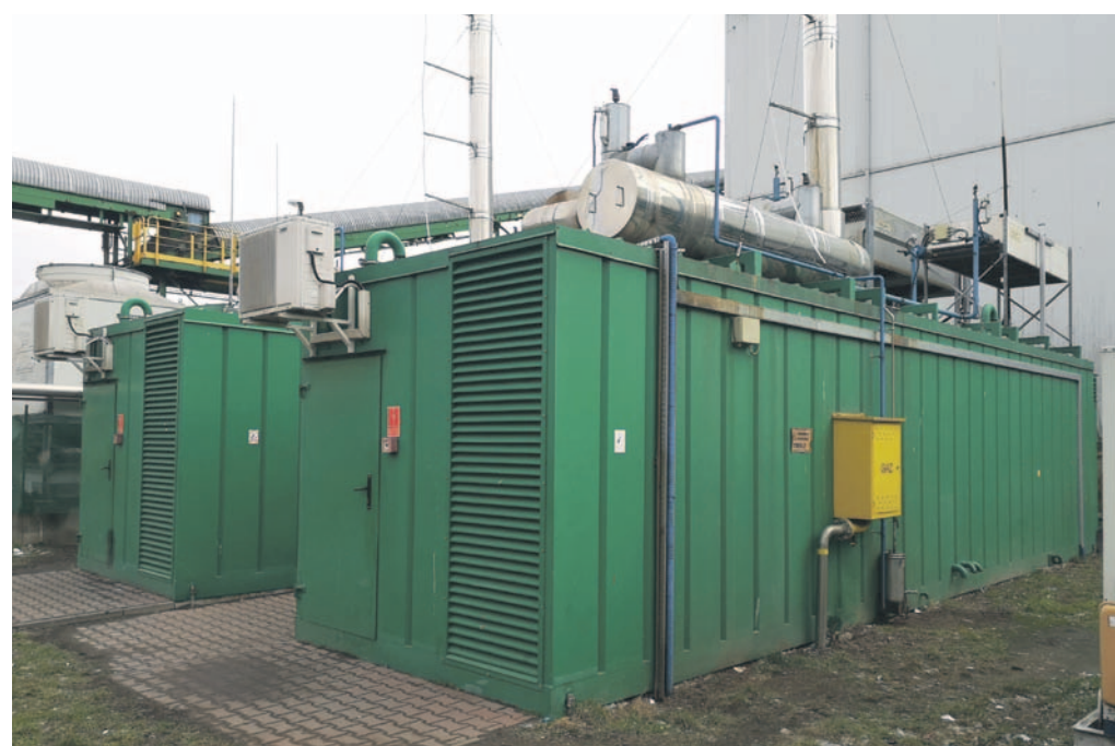
Tu są dwie jednostki kogeneracyjne, czyli silniki gazowe, sprzężone z turbiną elektryczną, produkującą prąd
