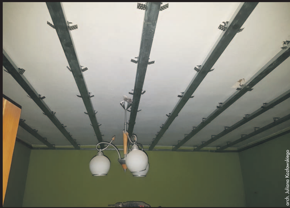
Prace remontowe trwają
