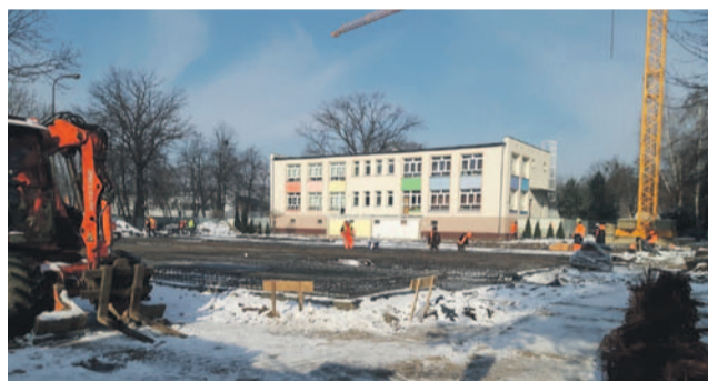
Prace przy budowie żłobka idą zgodnie z planem
