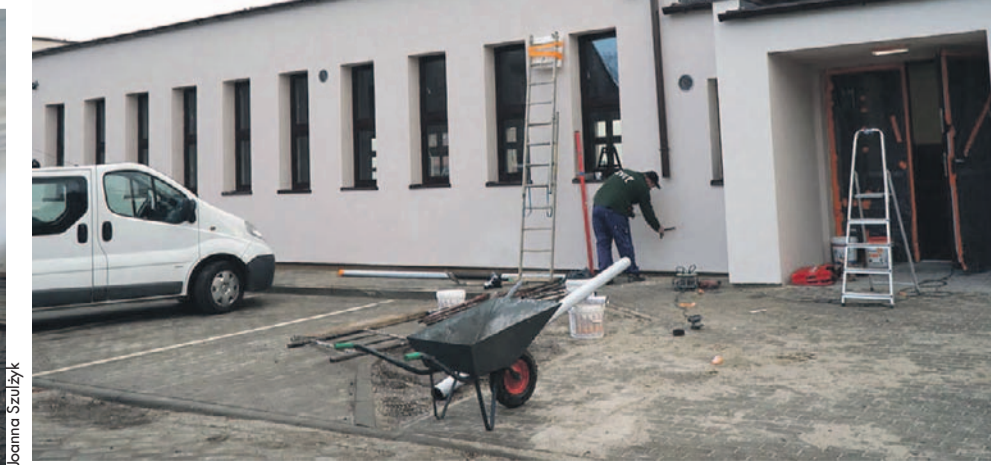
Remont zakładał także prace zewnętrzne
