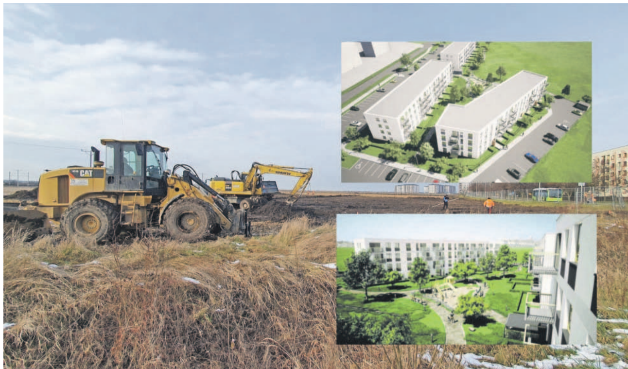
8 stycznia przy ul. Paderewskiego w Oławie rozpoczęły się pierwsze prace przy budowie budynków wielorodzinnych, które powstaną w ramach programu Mieszkanie Plus
