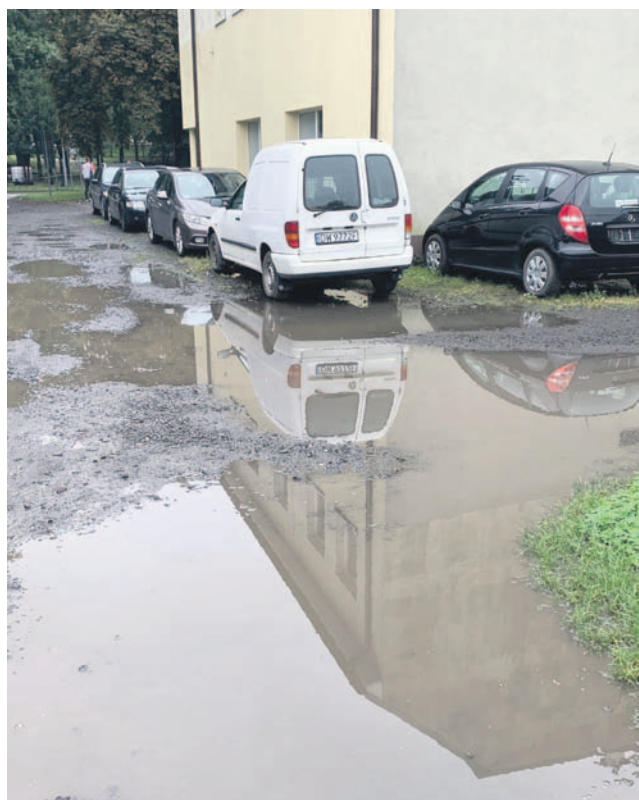
Tak po każdym większym deszczu wygląda to podwórko i wjazd na posesję
