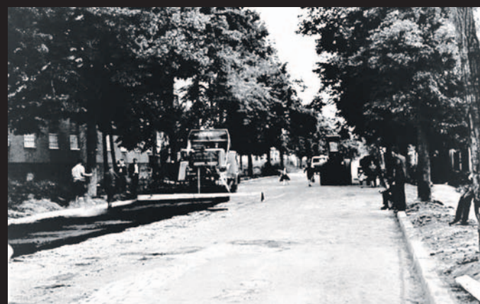
Ulica 3 Maja - w budynku po lewej były koszary Wojsk Sowieckich, za tym budynkiem był wjazd bocznicy kolejowej
