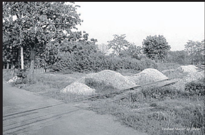
Zdjęcie wykonałem w 1965 r. - ul. Zwierzyniecka, na wprost za torami zostanie wybudowana piekarnia przez PSS Oława - po lewej widzimy część rampy, która była zamykana na czas przejazdu pociągu
