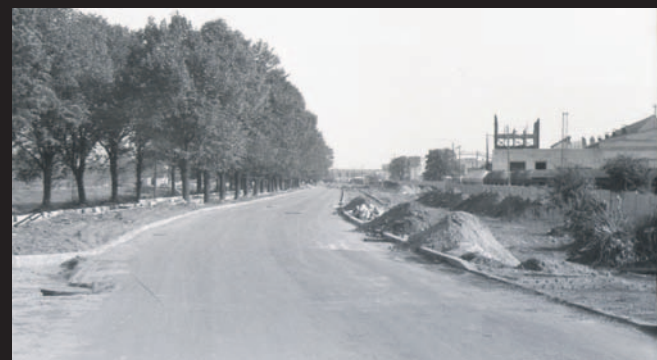
Pomiędzy drzewami po lewej była ul. Portowa - w lewo widzimy początek ulicy, która przez most na śluzie prowadzi na Zwierzyniec, a w miejscu nowego pasa drogowego na wprost była bocznica, na której prowadzono załadunek i rozładunek papieru do papierni. Po prawej widzimy zakłady ZNTK popularnie nazywany „Tajwanem”. Zaraz za płotem stoją wagony towarowe
