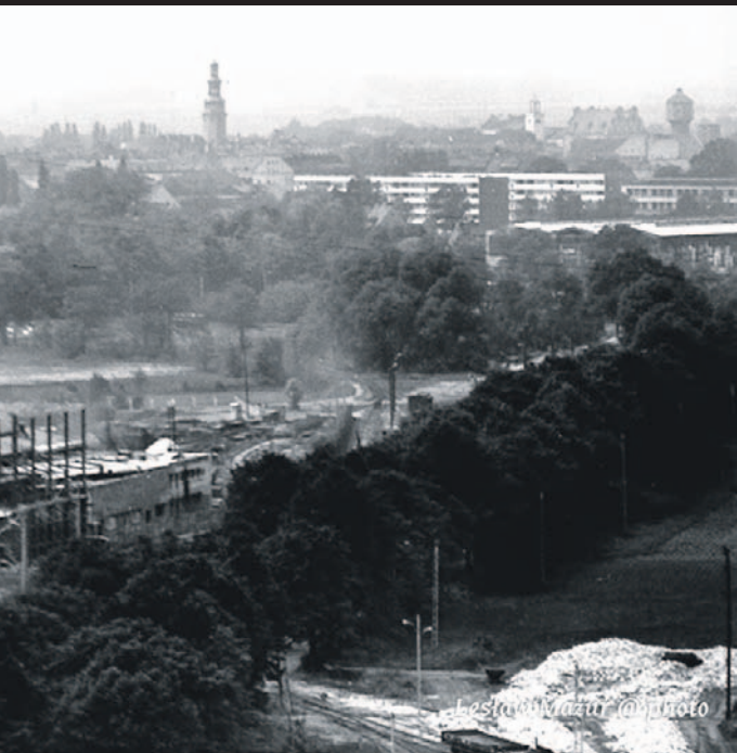
Portowej - po lewej zakłady ZNTK - „Tajwan”, a na dole po prawej tory na nich. Widoczny ciąg drzew to dawna ulica Portowa
