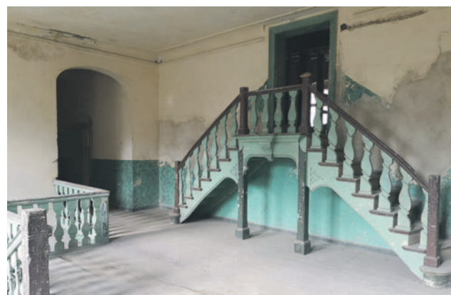
Niewiele oryginalnych fragmentów wyposażenia się zachowało, jak te barierki i schody
