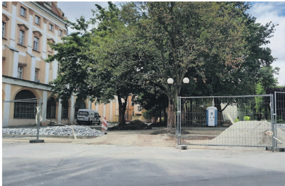
Na placu Piastów przed budynkiem Caritas od kilku miesięcy trwa remont, a teren budowy jest ogrodzony, więc w naturalny sposób dojście do budynków znajdujących się z drugiej strony placu jest ograniczone
